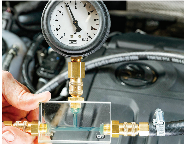
Bild 12 Bei verschiedenen Motordrehzahlen Vorförderdruck ablesen und mit herstellerseitigem Solldruck vergleichen
